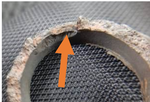
Foto 05 – Vista da superfície de ruptura da região de solda, com indicação do início do dano, com deformação.
