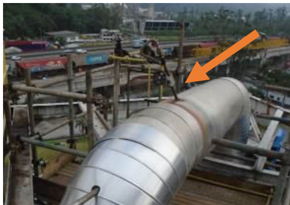
Foto 01 – Posição do tie-in de 3/4" onde ocorreu o rompimento durante campanha de produção de estireno, objeto desse estudo.
