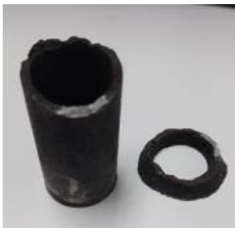
Foto 04 – Vista do tie-in de ¾" removido da tubulação.
