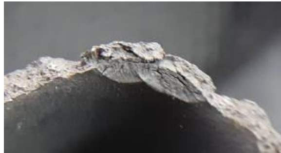
Foto 11 – Vista das trincas visuais no interior do tubo de \frac{3}{4} ", na região da ruptura, com trincas características de sensitização.
